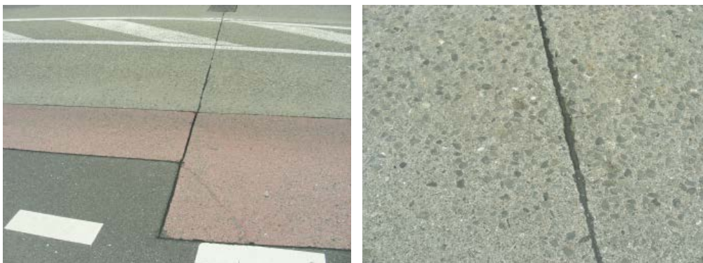
Abb. 36 Betondecke Rinächt Erstfeld, erstellt in den 1960er Jahre. Foto H. de Witte (Mai 2013).
