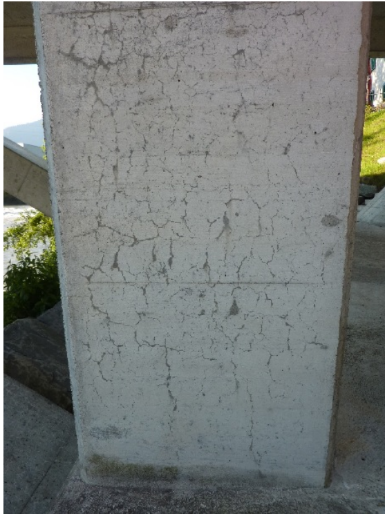
Stütze Seite Mastrils unterwasserseitig
