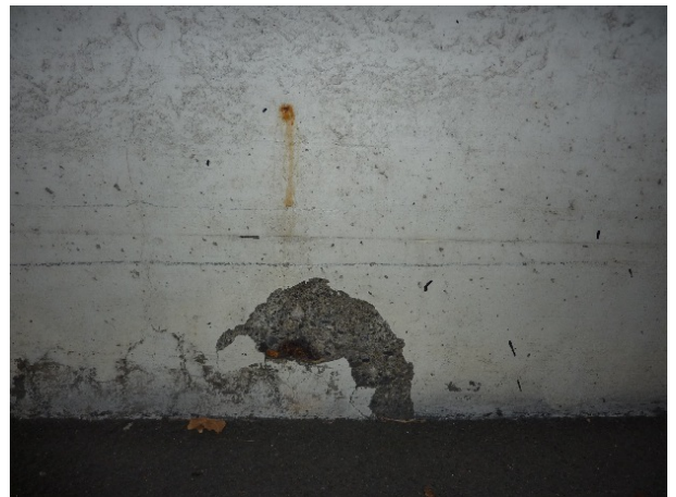
Wand Richtung Einigen
