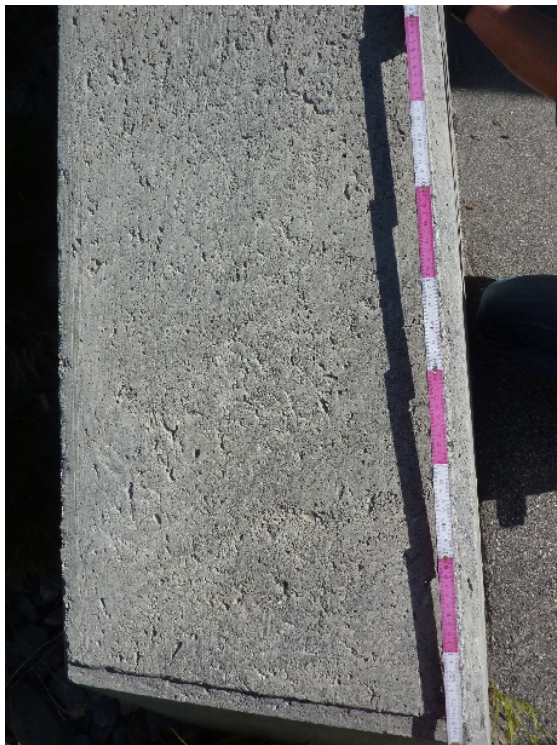
Portal S/W, Flügelmauer Rtg. Laax
