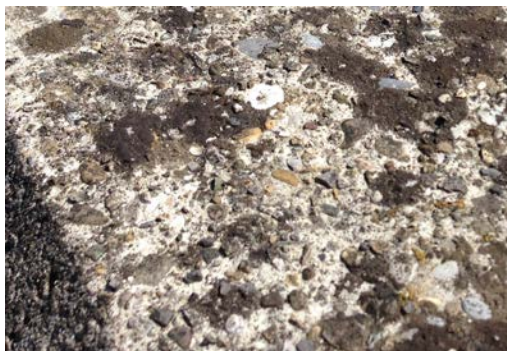
Abb. 33 Oberflächliches Absanden und Abplatzungen bei Kunstbauten im Kanton Zürich. Foto K. Lang, TBA Kt. Zürich, April 2014.
