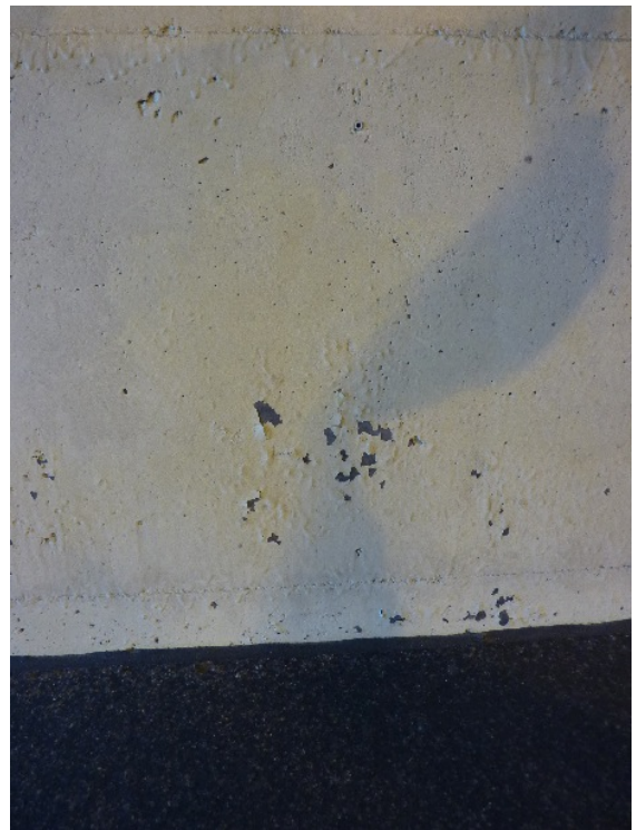
Tunnel Fahrtrichtung S-W
