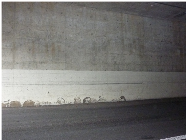
Wand Richtung Einigen
