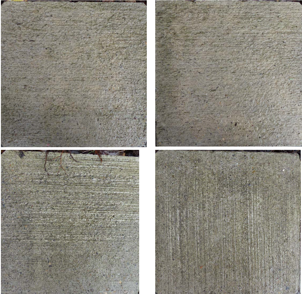
Abb. 19 Zustand der Versuchsplatten am 14.05.2014. Oben: Beton 3. Unten: Beton 8 (jeweils linke und rechte Platte, Blickrichtung Südwesten).
