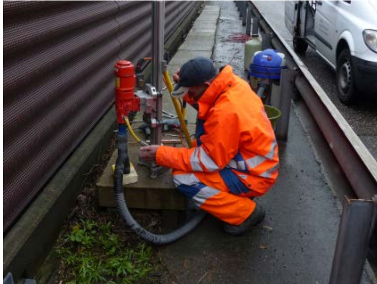
Abb. 22 Entnahme der Bohrkern am 14./15.05.2014.
